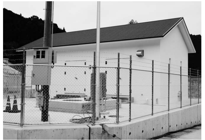
3月末に工事完了予定の栗栖川簡易水道（伏菟野地区）施設
