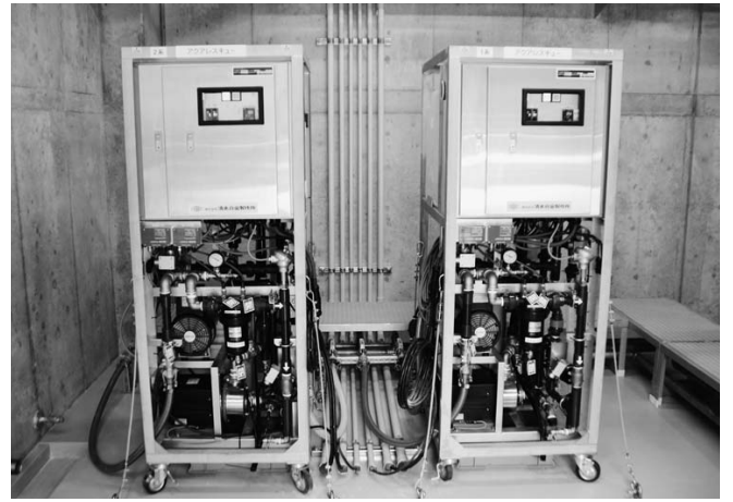
通常は2台を自動で並列運転し、非常時には1台を被災現場等に搬入する
