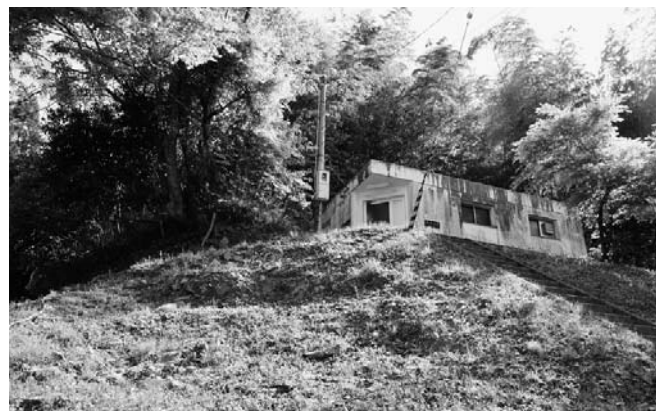
地下には40立方メートルの配水池がある境浄水場
