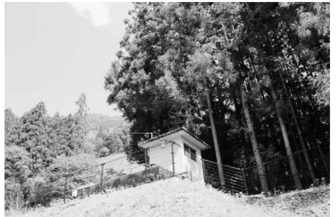
狭隘な既存浄水池のスペース
