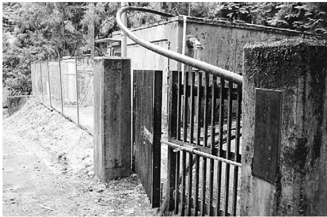
躯体への被害は免れた乙河地浄水場
