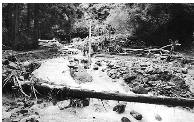
大量の土砂が取水口を破壊
