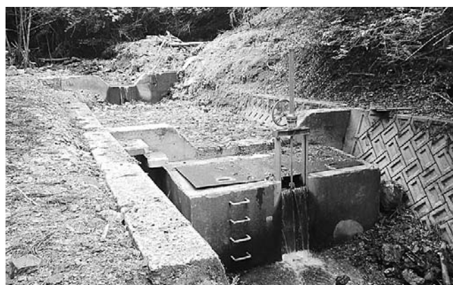
復元後の取水口
