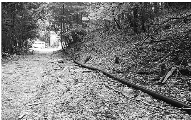
浄水場への導水管も仮設で対応している
