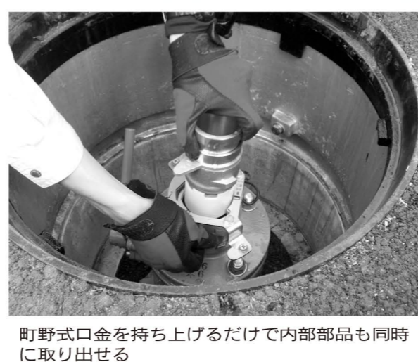
町野式口金を持ち上げるだけで内部部品も同時に取り出せる
