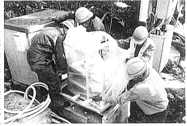
狭小地形でも人力で搬入プレハブ構造なので据付も容易
