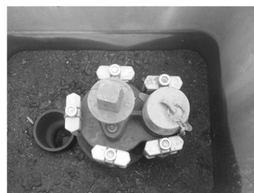
図5 現場での補強金具取付け状態
