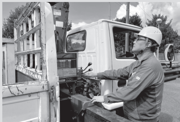
工事現場でのクレーン操作も慣れた手つきで
