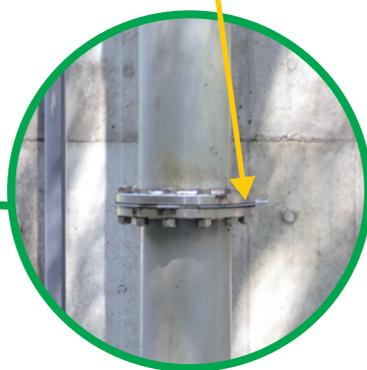
屋外タンク横に設置された、呼び径200 ステンレス鋼管（縦配管）に使用
